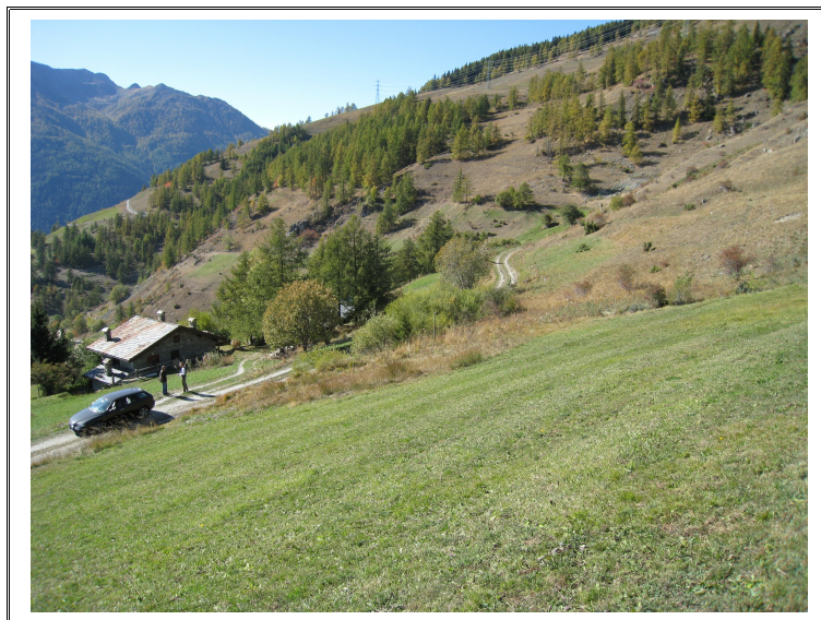
Settore vasca di carico
