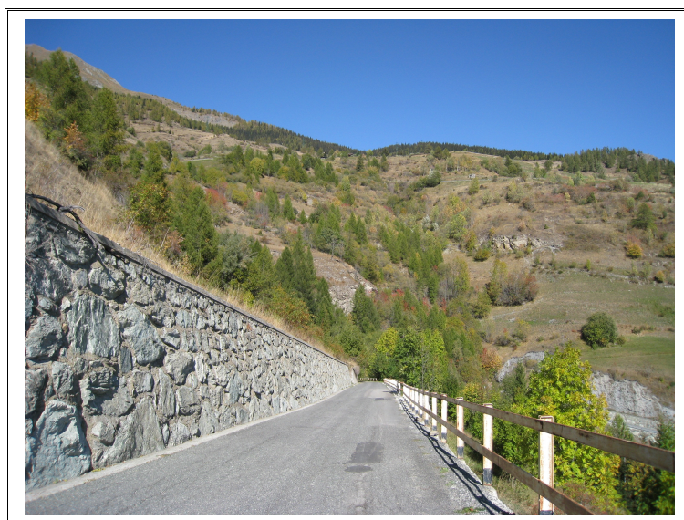
Vista del tratto mediano della condotta
