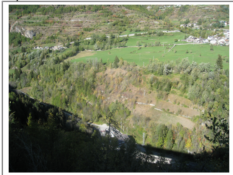
Vista dei piani di Ville e della scarpata posta a monte della centrale
