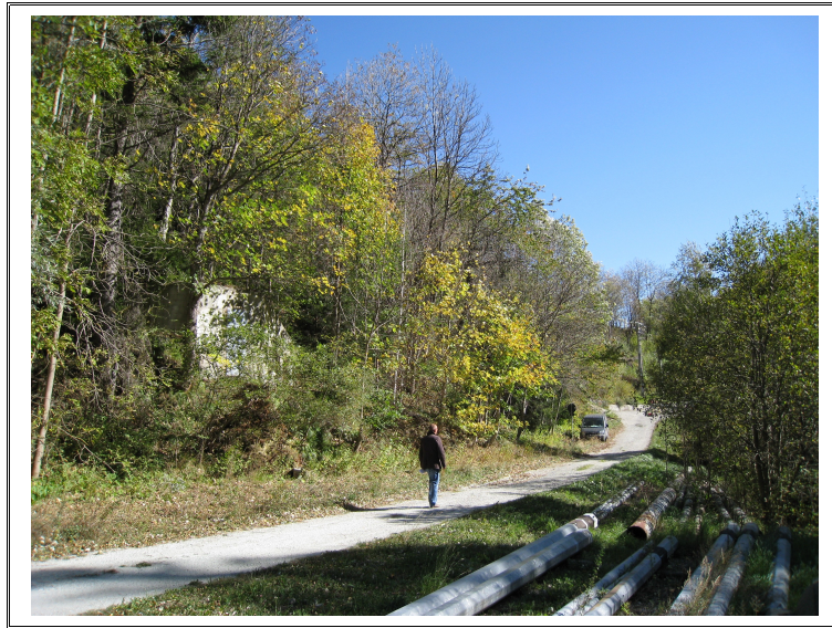
Vista del sito dove verrà realizzata la centrale.
