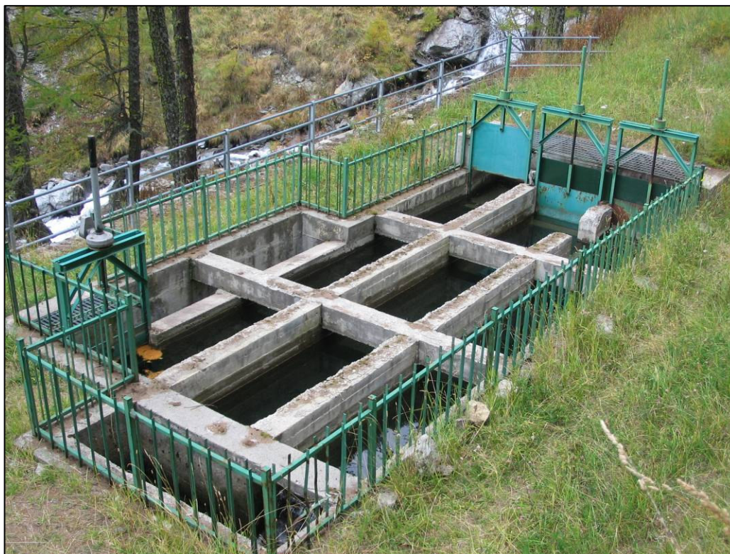
Figura 3: opera di presa del a trappola del Ru d'Allein sul torrente Menouve fotografata da monte
