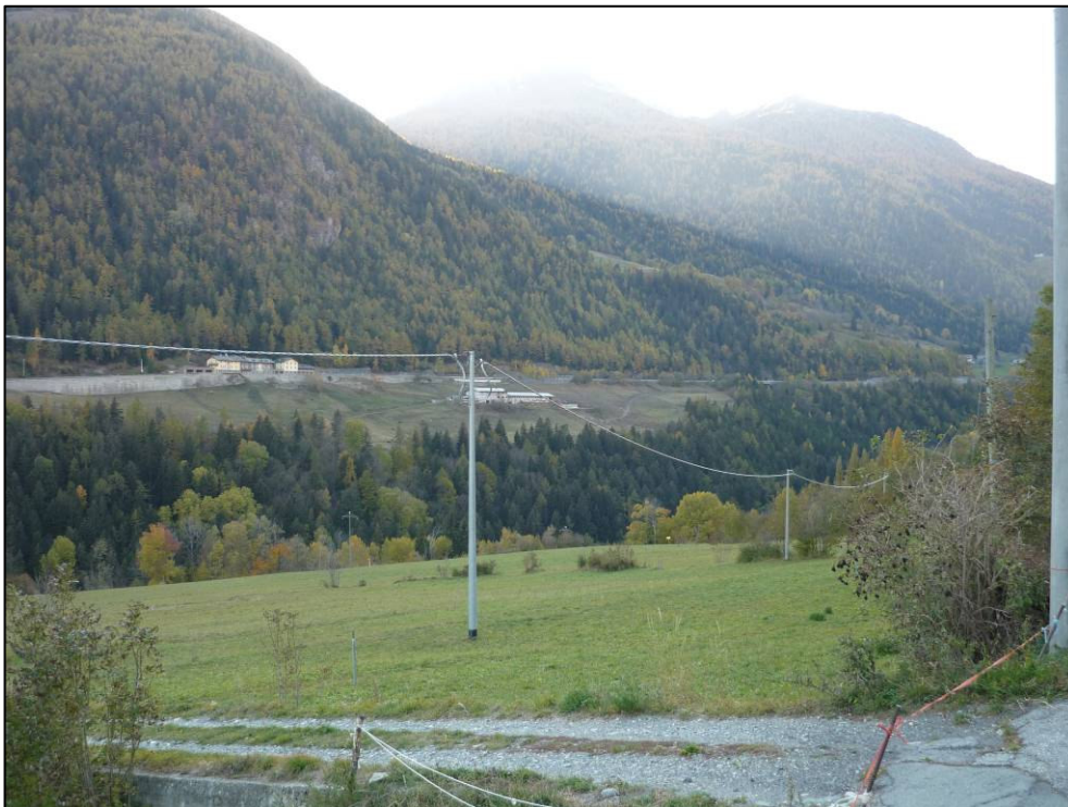
Figura 10: Vista da est del Plan d'Allerod, dove è prevista la posa dell'ultimo tratto della condotta in pressione. In evidenza i detrattori lineari costituiti dalla linea elettrica. Sullo sfondo la località La Clusaz, punto di visuale panoramico del versante oggetto di intervento.
